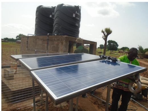
De watertanks en zonnepanelen in Badim Suguru tijdens plaatsen
