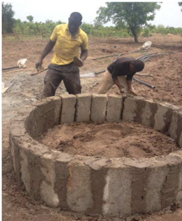
Leggen fundatie voor 2000 liter tank
