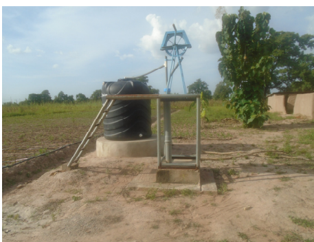
Tank met touwpomp
