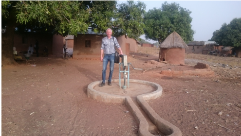
Sijtse tijdens de eerste inspectie van een gerenoveerde touwpomp waarvan er nog 84 zouden volgen.
